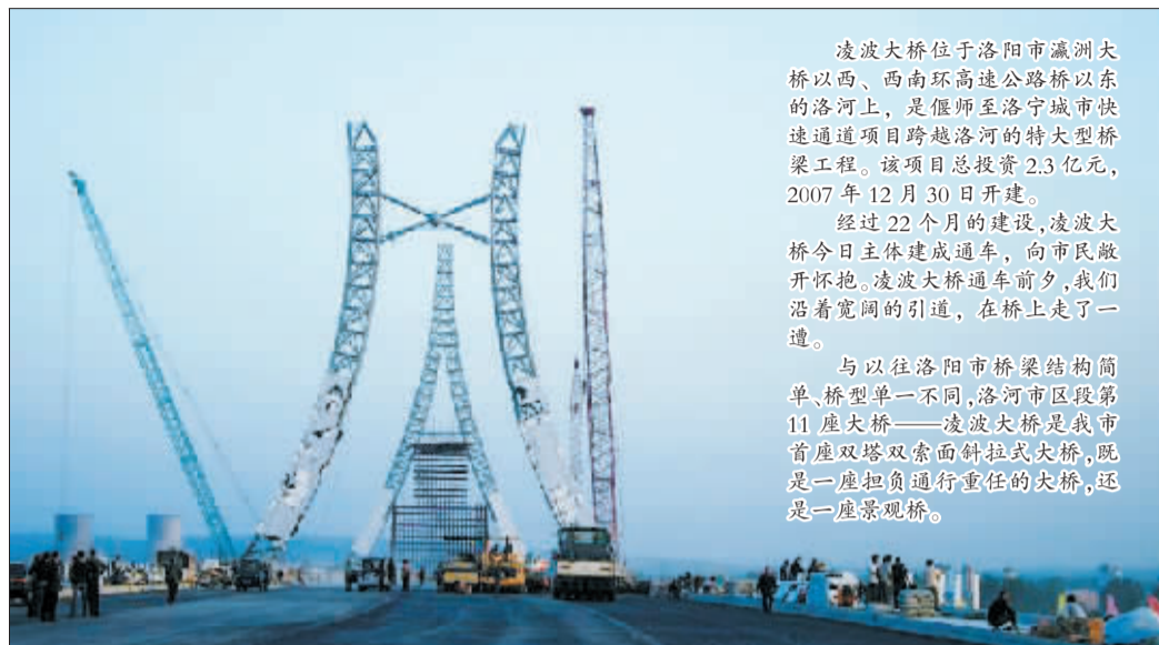
9月22日，正在建设中的凌波大桥。网友“洛阳兄弟 0379”摄
