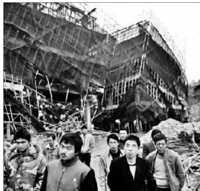
整栋楼扭曲成弧形，脚手架和水泥柱向一侧倾倒，摇摇欲坠。（资料图片）
