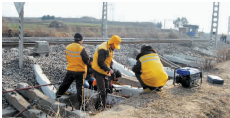
铁路工人们正紧张作业。
