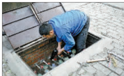
工作人员用电吹风机加热管道。
