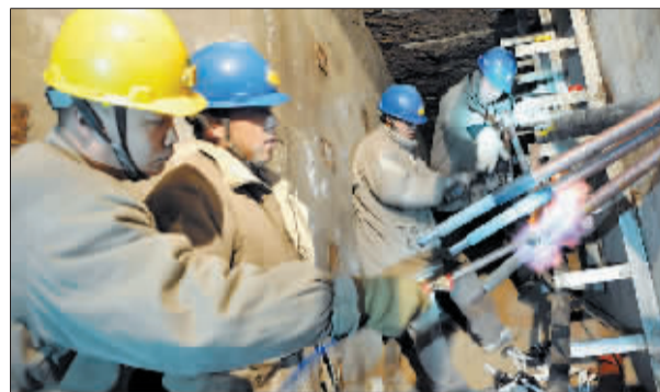
抢修人员在抢修线路。 记者 梅占国 摄
