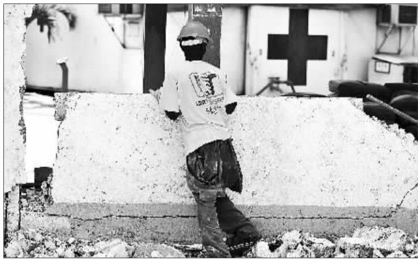
1月26日,在海地首都太子港市区,一名工人准备将被地震损毁的一个医疗机构外墙推倒重建。(新华社发)
