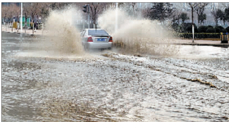
供水主管道破裂 居民用水受影响
