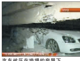
汽车被压在垮塌的房屋下。
