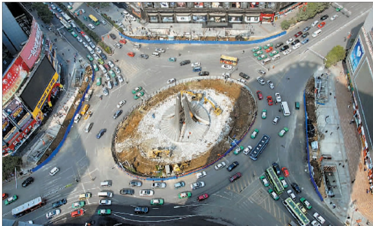
贵阳地标建筑 喷水池环岛拆除
