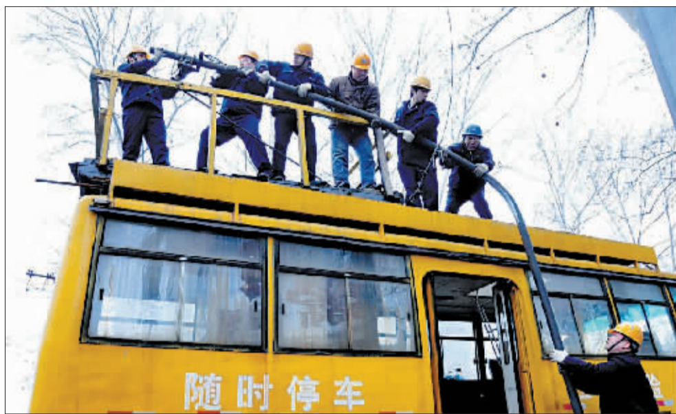
公交集团维修人员在全力抢修电车线路。
