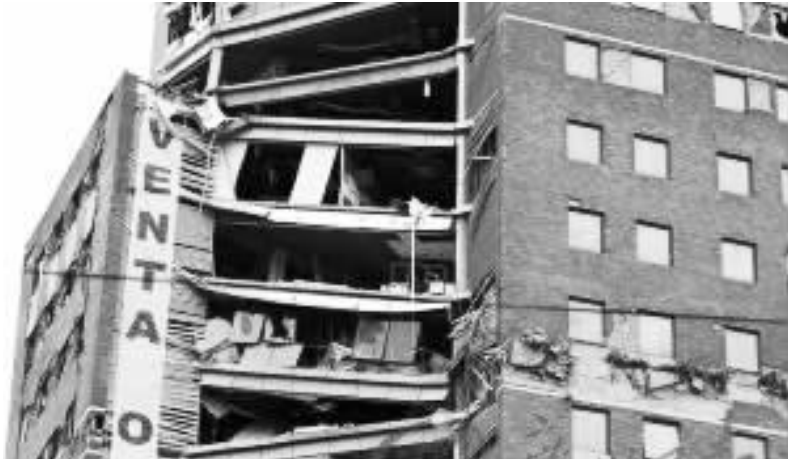
智利中部康塞普西翁市，一栋正在发售的办公楼因为“强柱弱梁”的设计而屹然不倒——虽然部分楼层楼板已经坍塌。(资料图片)
