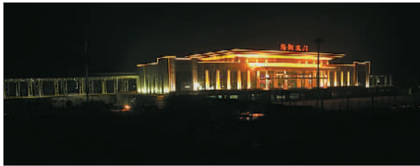
高铁洛阳龙门站熄灯后。记者 杜武 通讯员 杨世欣 摄
