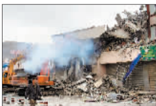
清理受损房屋的外立面。
