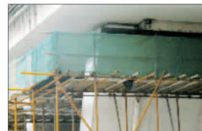
牡丹桥北引桥加固工程开工。
