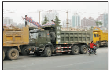
西小屯拆迁工地,窄窄篷布难遮车斗。李建民 摄
