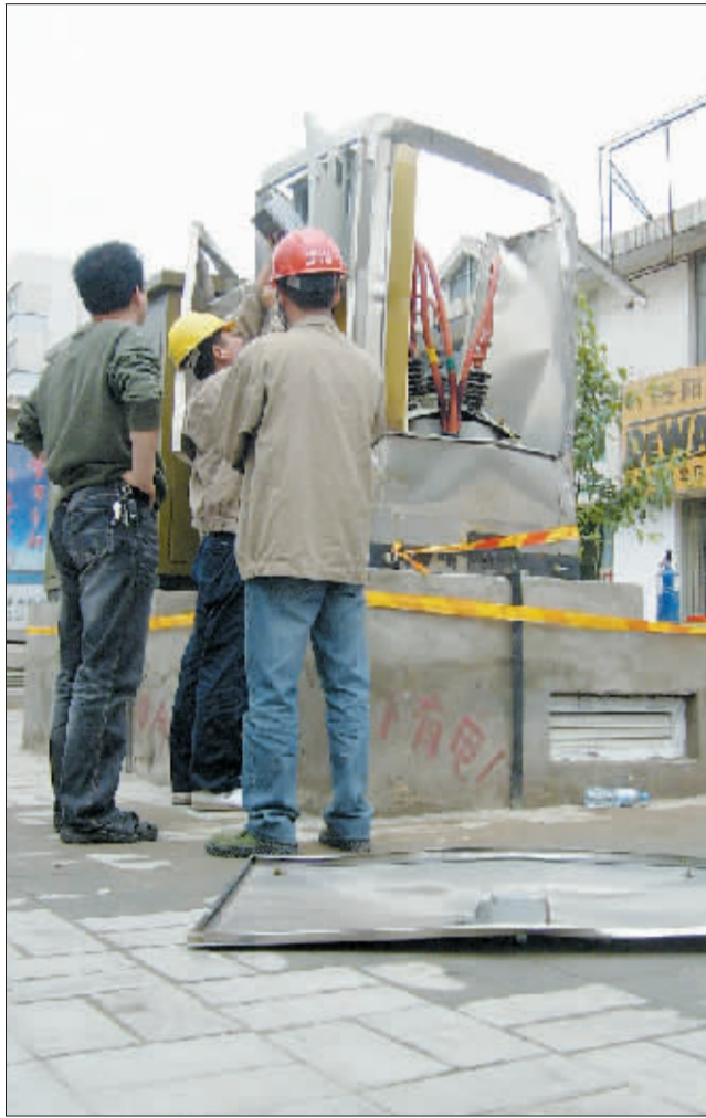
相关人员正在进行维修。
