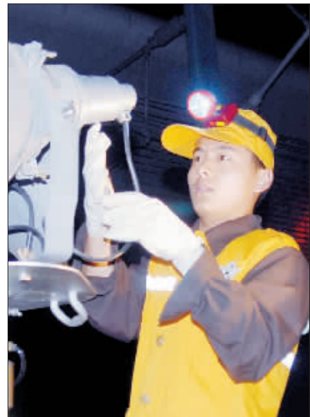
更换带有病害的钢轨扣件。 工作起来一丝不苟。
