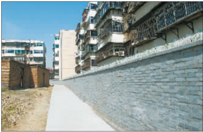
五六小区新建的围墙。
