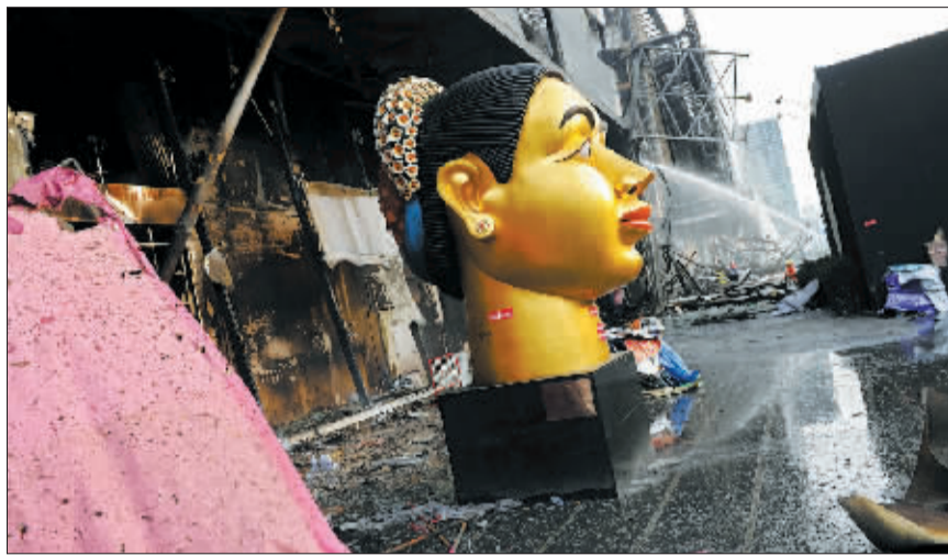
5月20日，在泰国曼谷，消防员正在扑灭世贸中心商场余火。(新华社发)
