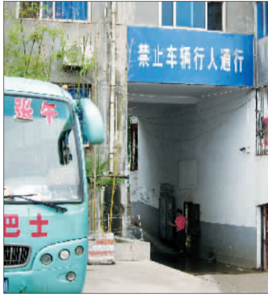
汽车站进站口有明显的“禁止车辆通行”标志。
