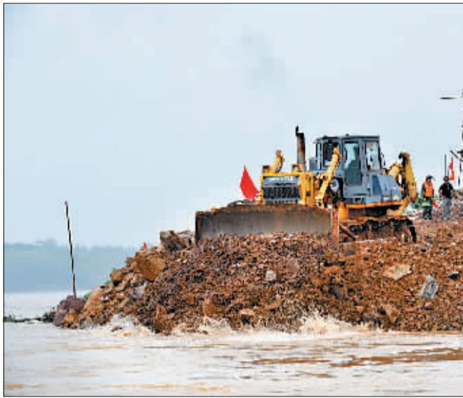
6 月 25 日,推土机在唱凯堤一处决口填沙石。(新华社发)
