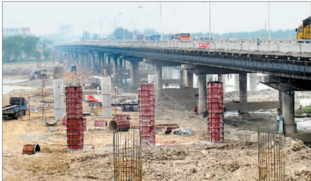
新洛阳桥施工现场
