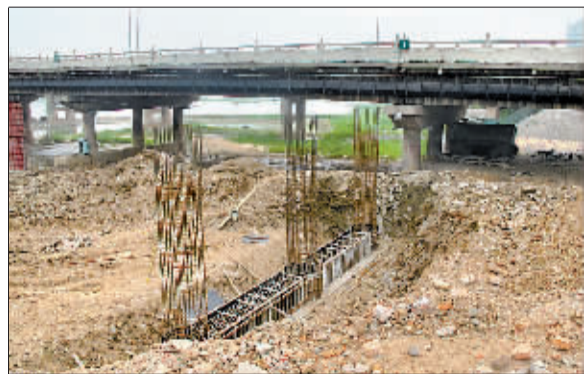
桥墩骨架成形
