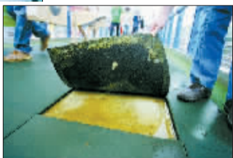
东风路文化路天桥桥面上的塑胶板下面积满了水。
