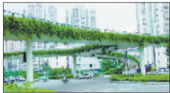
广州天桥的护栏被绿色植物覆盖。
