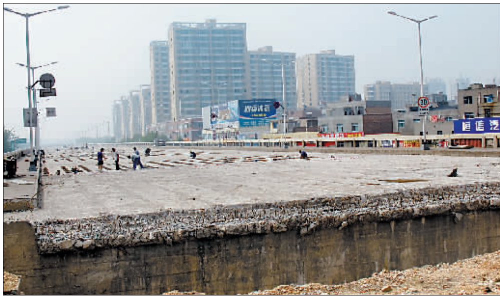
牡丹桥引桥部分桥面被拆除。
