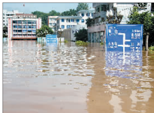
7月19日,靠近渠江一带的广安市老城区街道一片汪洋。由于四川渠江上游连降暴雨,形成特大洪水,导致中下游的广安市老城区靠近渠江一带每条街道不同程度进水,抗洪形势严峻。新一轮特大洪峰来袭前,该市共转移群众15万人。(新华社发)
