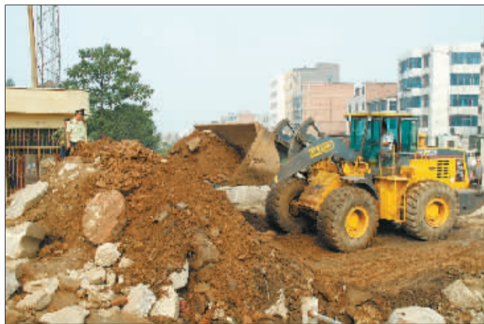
新安东关立交桥抢修工地上，工人正在施工。
