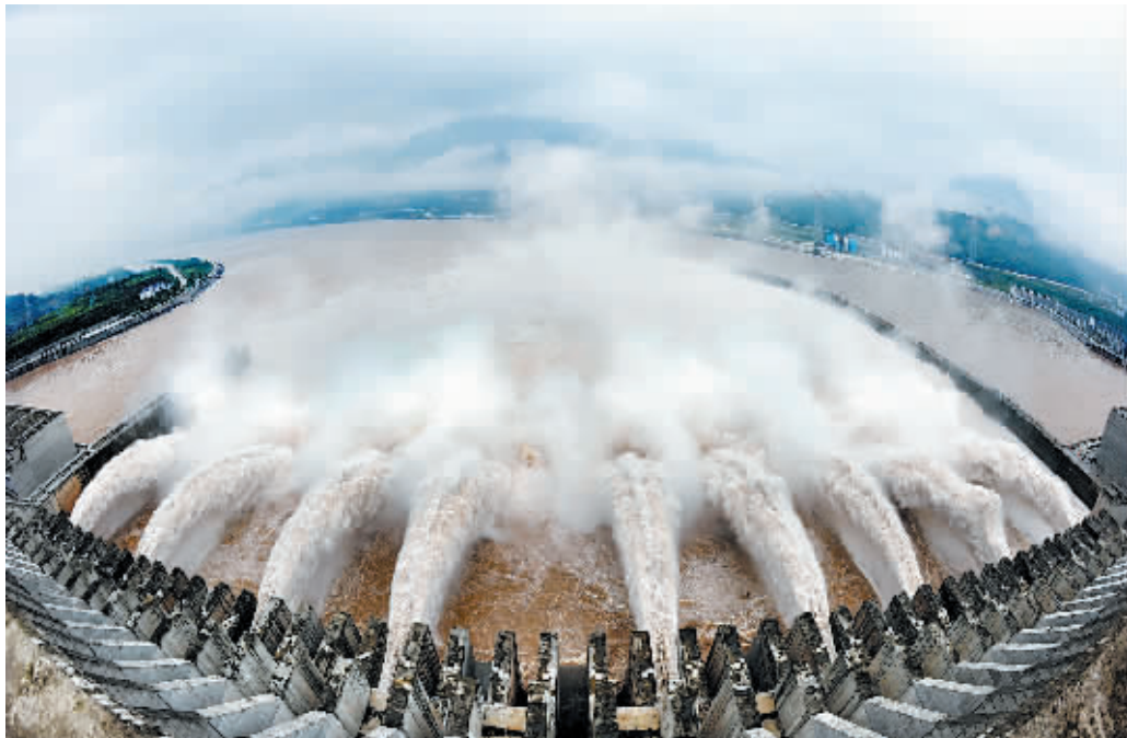
7月20日上午,三峡大坝开启9个深孔泄洪,下泄流量控制在4万立方米/秒。(新华社发)
