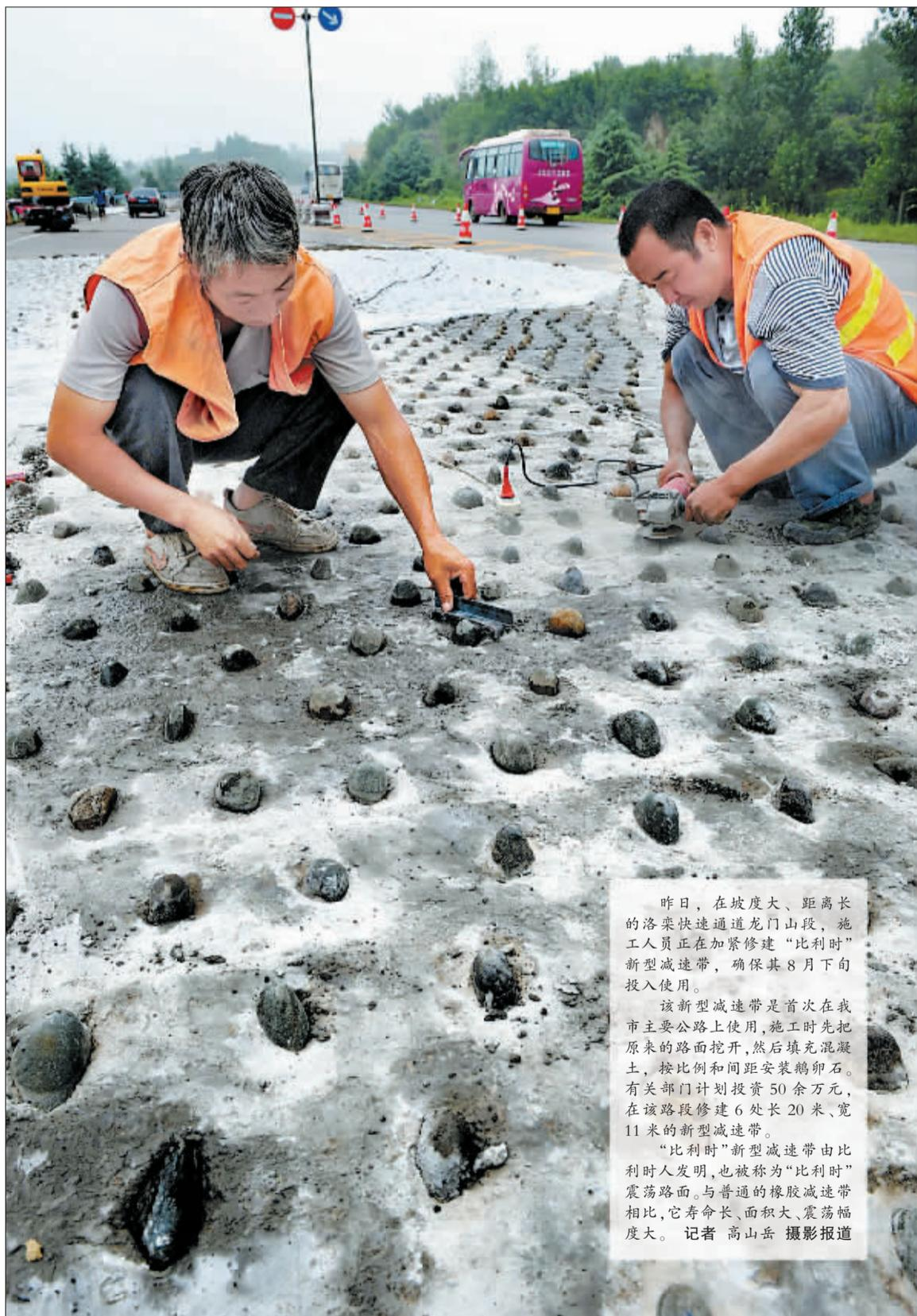
昨日,在坡度大、距离长的洛栾快速通道龙门山段,施工人员正在加紧修建“比利时”新型减速带,确保其8月下旬投入使用。
