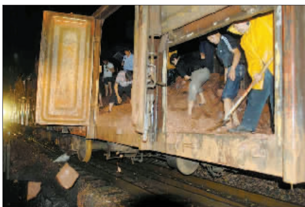
铁路职工在往塌方处抛填片石。
