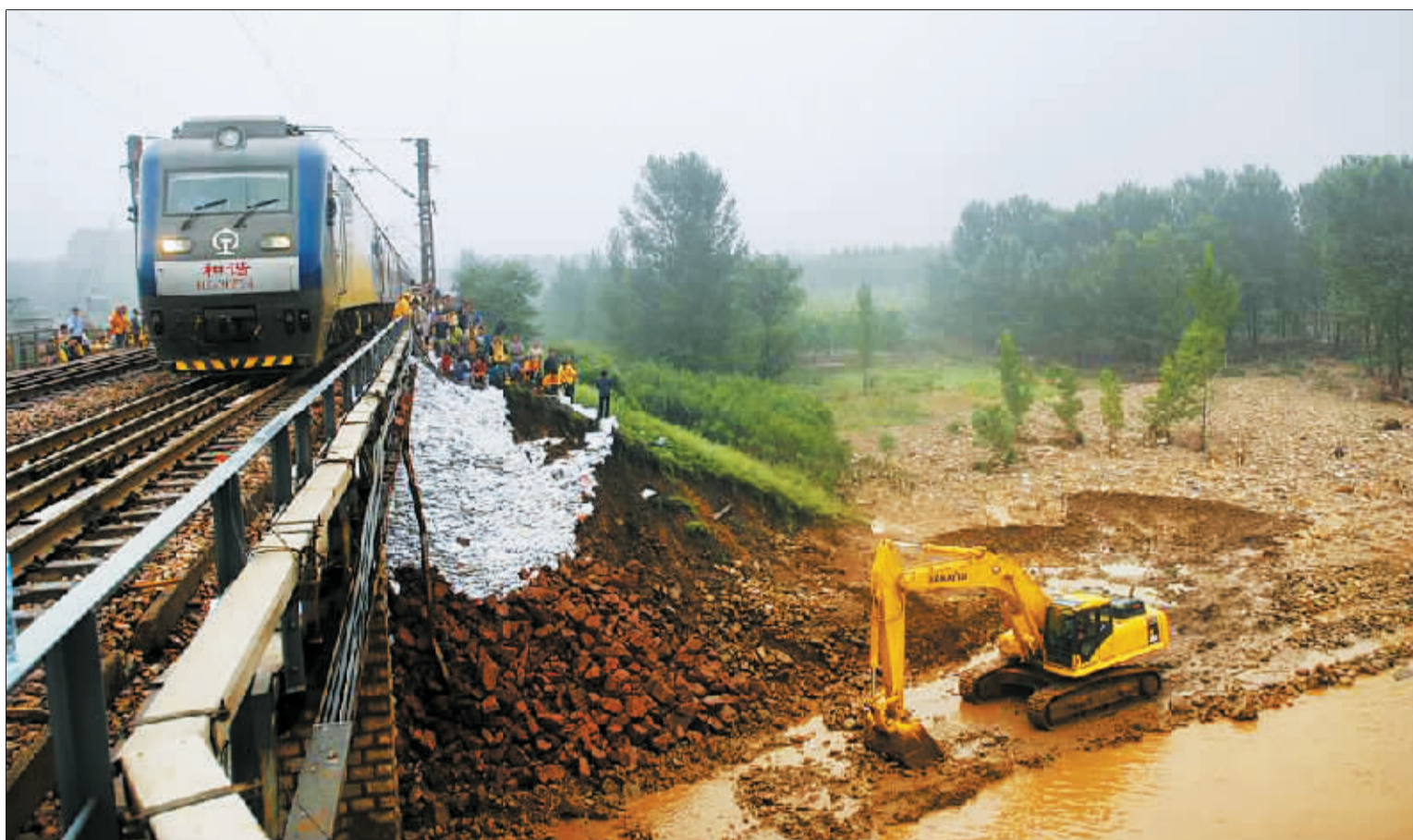
列车缓慢驶过抢修后的塌方处。
