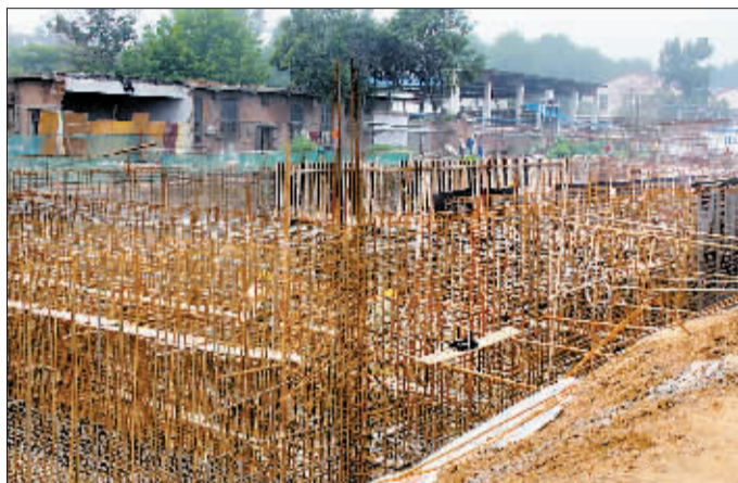
东区热源厂施工现场。
