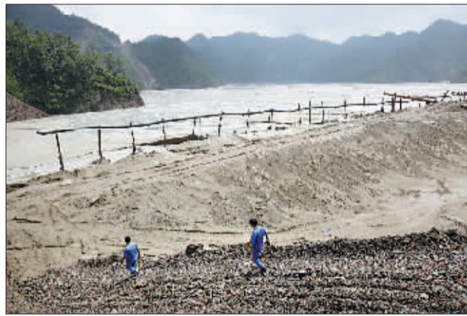
安监人员在炉场沟尾矿库排查。
