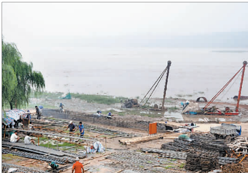
施工人员在抢修设施恢复施工。
