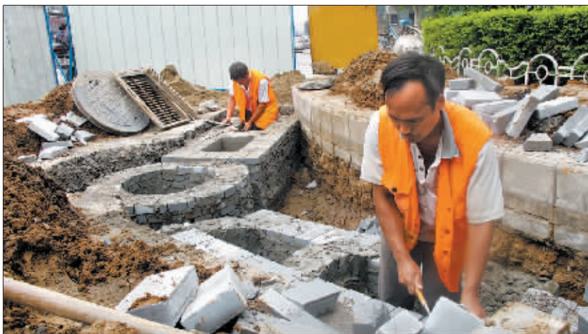
市政工人在延安路珠江路口紧张施工。
