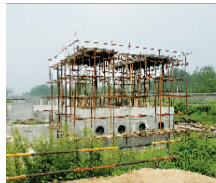
施工现场一角
