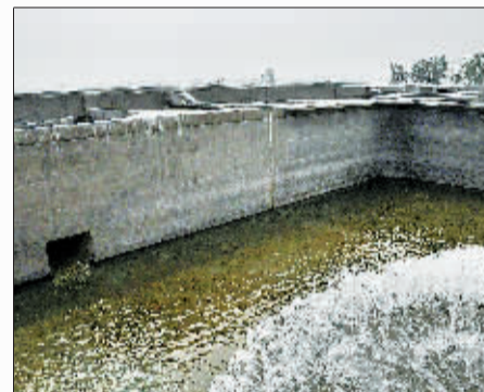
二沉池闭水试验
