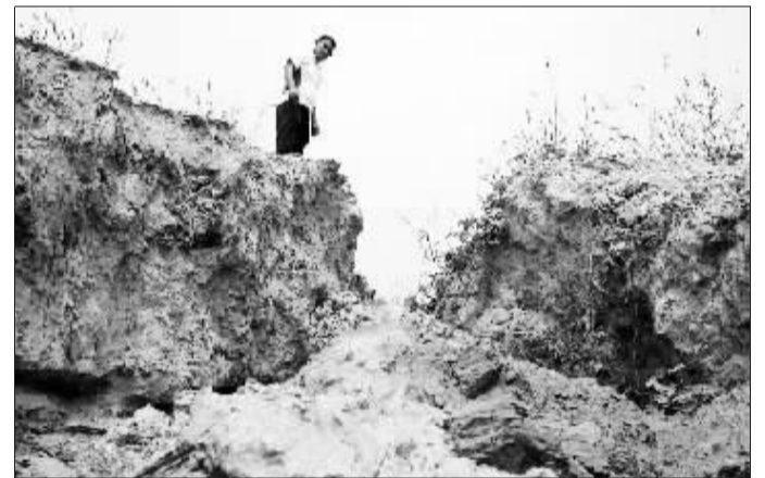
一场中雨过后,刚建成两个月的大坝就被冲成了这样。
