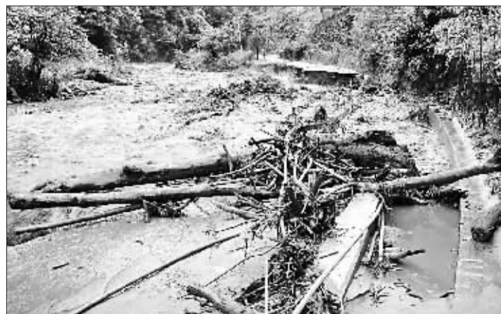
汶川县一段路面被泥石流冲毁。
