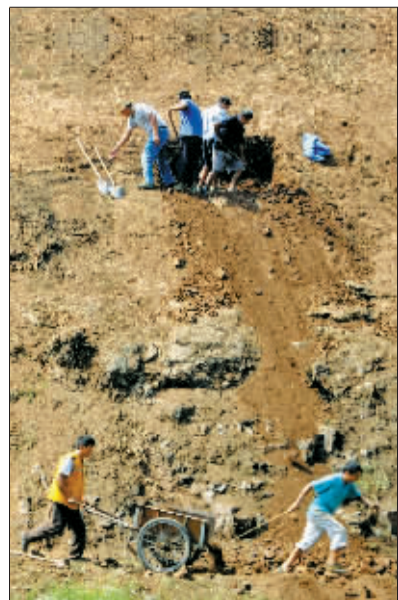
对陇海铁路旁的山坡进行防护加固。
