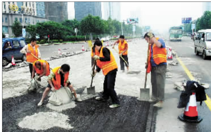
市政工人在开元大道上施工。
