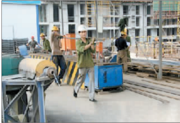
一个被检查项目部开始使用自己加工的钢筋。
