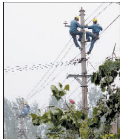
孟津县电力工人抢修电力设施。赵茂平 摄
