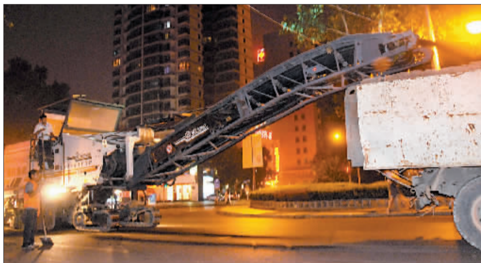
大型铣刨机9月3日夜间在凯旋路进行施工作业。
