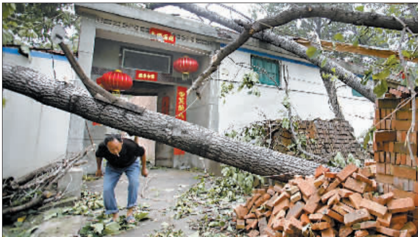
被刮倒。孟津县白鹤镇沟口村一农民家门口的大树
