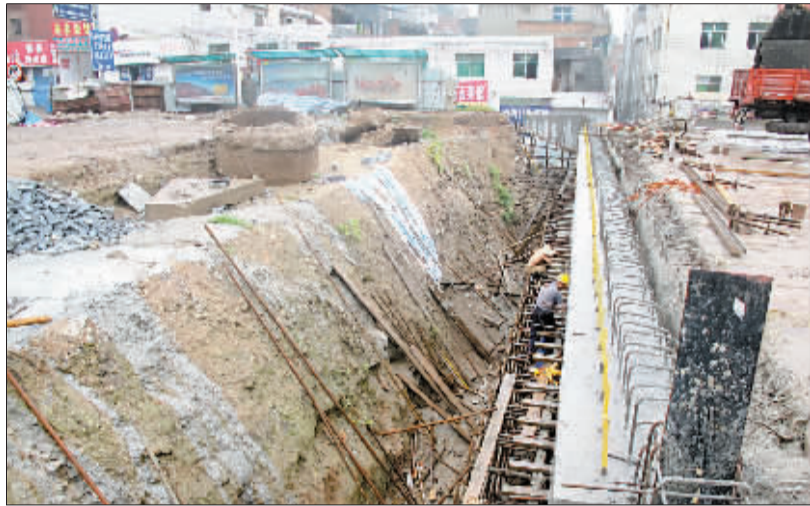
工人在牡丹桥北引桥与解放路的连接处施工。
