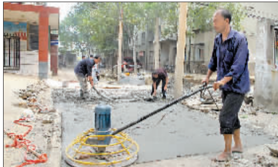
施工人员在修复丽春路春光园小区前的道路。
