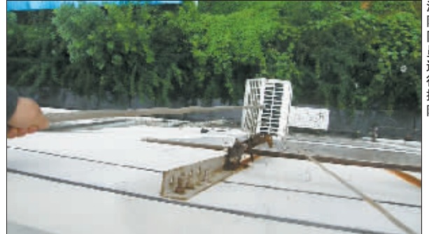
消防队员进行排险。
