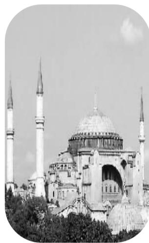
据说，土耳其伊斯坦布尔的圣索非亚大教堂改变了建筑史，它开创了间接荷载传递的理念，该建筑的设计师大胆地说，穹顶不必从上直通地面。相反，穹顶能以扇形的方式通向更多的圆顶。这一方法的应用促进了建筑业的大发展。它建成后一度成为世界上最大的礼拜场所，直到1520年建造了塞维利亚大教堂。
