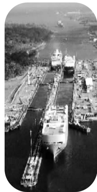
在1904年至1914年修建的48英里（约77公里）的巴拿马运河简直是个奇迹，它不只是连接大西洋和太平洋的通道，而且提高了运河本身的价值。出人意料的是，海平面在每个海岸是不同的，并有不同程度的涨潮。为了解决这个难题，他们必须打造三个宽110英尺（约33.5米）的水闸，并且水闸墙壁的厚度设置为底部50英尺（约15米），顶部10英尺（约3米）。它的设计航运量为每年8000万吨。如今，它每年承载着2.3亿吨的航运量。
