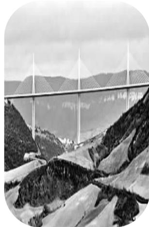
米洛大桥位于法国南部，法国政府花了巨大的人力物力才建成这座横跨塔恩河的斜拉索公路桥。其最高混凝土桥塔高达800英尺（约244米），比当地大多数建筑都高。据测量，从河面到塔顶的高度为1120英尺（约241米）。
