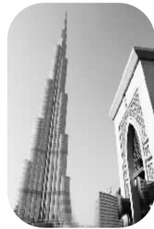
到目前为止，高层建筑一般不超过1500英尺（约457米）高。然而迪拜塔却有2700英尺（约883米）高。它的建筑中有一个支撑核心：一个坚固有脚的中心部分将建筑物支撑起来。
