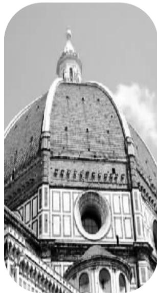
意大利佛罗伦萨大教堂穹顶于1420年至1436年建造，虽然横跨长度为140英尺（约42米），但此穹顶在建造时并没有使用可支持的框架。建筑工程师菲利普·布鲁内莱斯基在设计建造该穹顶时曾大胆预言，无需任何内部脚手架，这在当时是不可想象的。但是，他发明了一种全新的方式——分担圆顶周围的荷载，使圆顶不会分裂。他还把一些石头和铁紧密粘在一起，形成锁链，并用八字斜纹砖堆砌保证了圆顶不会开裂。
