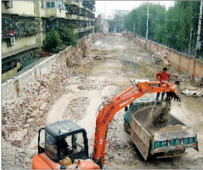
施工方准备在离居民楼约1米远的空地上建房。
