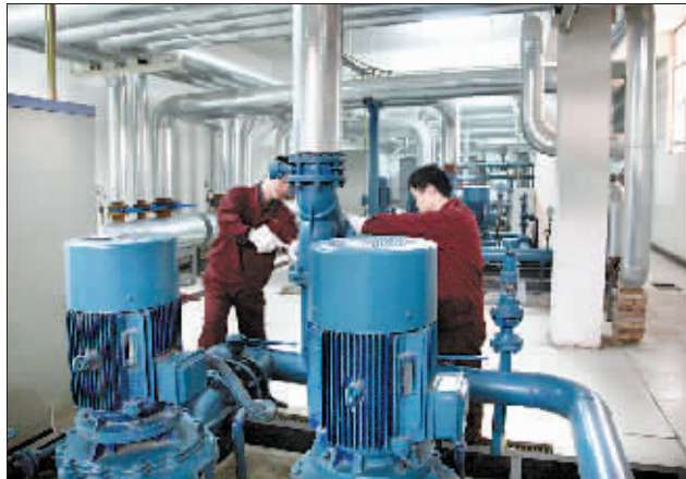
工人正在检修供热设备。
