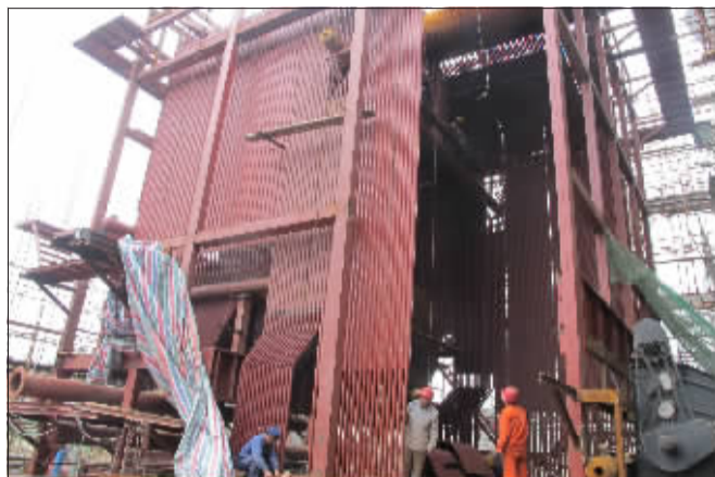
工人们正在东区热源厂安装供热设备。
