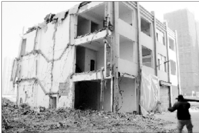
门窗没了,水电停了,俩八旬老人已在这里守了半个月。
