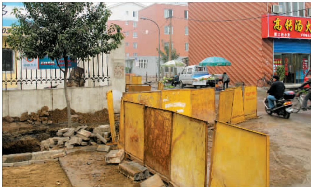
华山家园小区的暖气管道施工被迫暂停。
